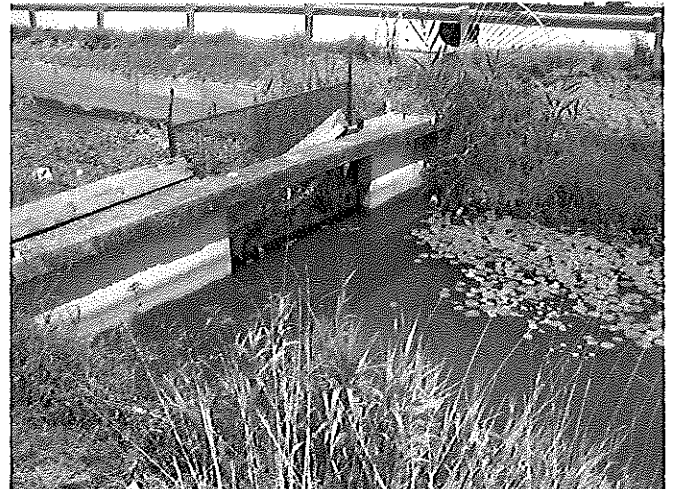
Foto 6. Sostegno a valle del tratto in oggetto, lungo Via Albersano.
