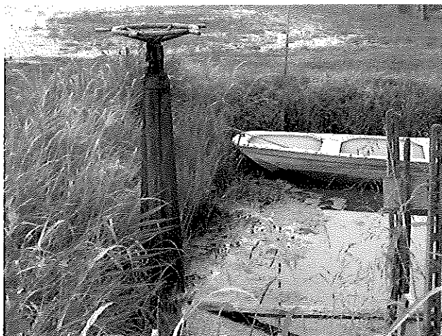
Foto 3. Saracinesca di regolazione del deflusso della F. Lavezzola alla intersezione con Via Bellaria
