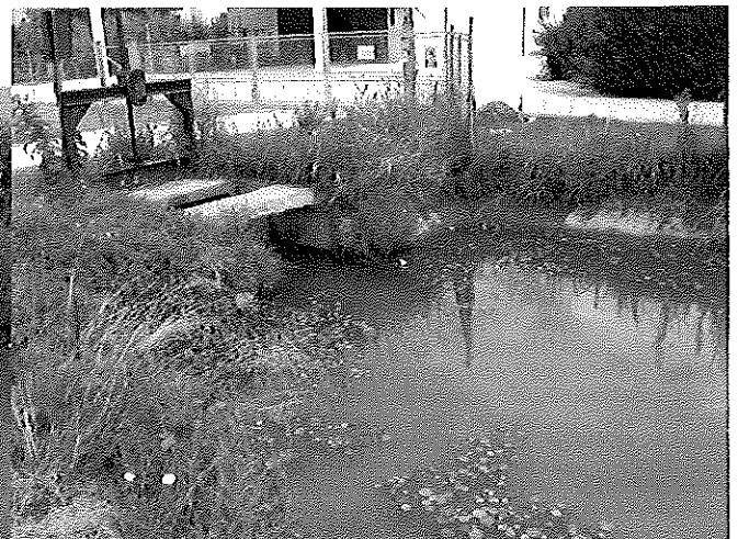
Foto 5. Manufatto al termine del tratto tombinato, in località Ponte Farmacia.
