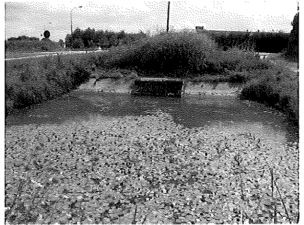
Foto 4. Vasca e griglia, immediatamente a valle del manufatto idraulico, prima della intersezione con Via Bellaria, dove inizia il tratto tombinato.
